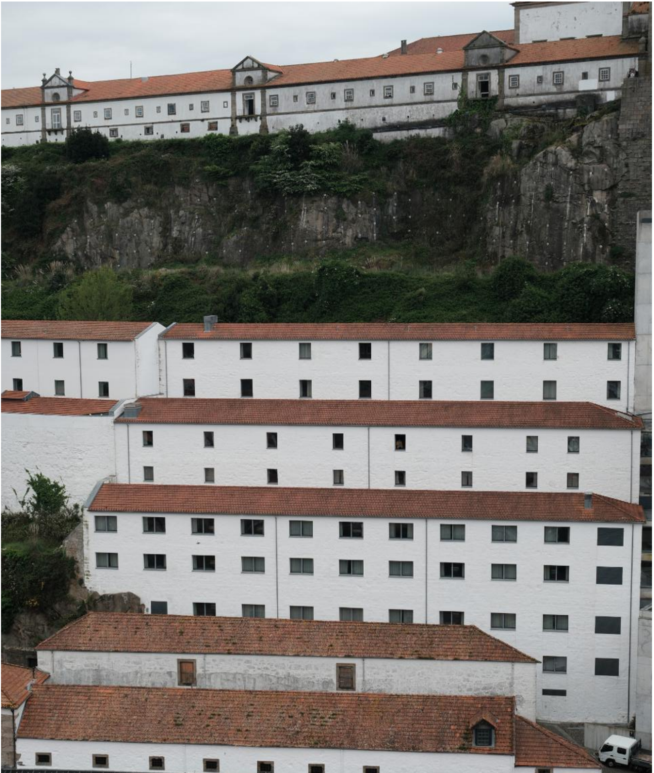
Weisse Gebäudereihen mit roten Ziegeldächern am felsigen Ufer von Vila Nova de Gaia.
